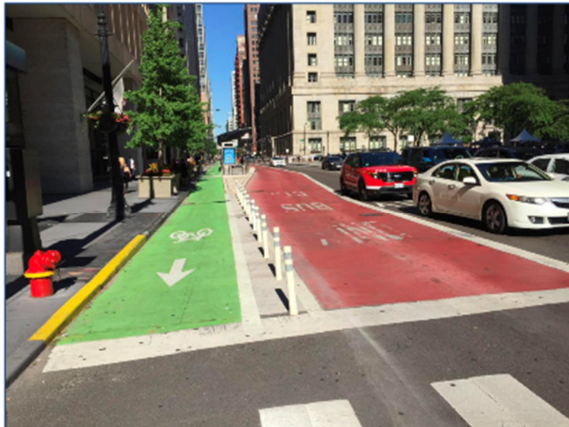
Abbildung 57: Gestaltungsbeispiel Protected Bike-Lane (Quelle: Positionspapier „Geschützte Radfahrstreifen“ ADFC, Seite 11)
