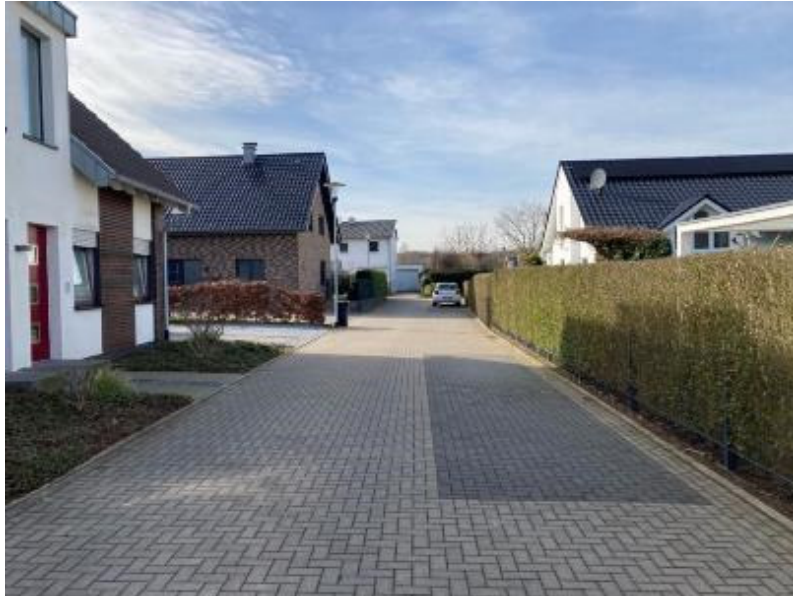
Abbildung 75: Ausbau eines verkehrsberuhigten Bereichs in einem klassischen Wohngebiet im Mischprinzip (Quelle: eigenes Foto)
