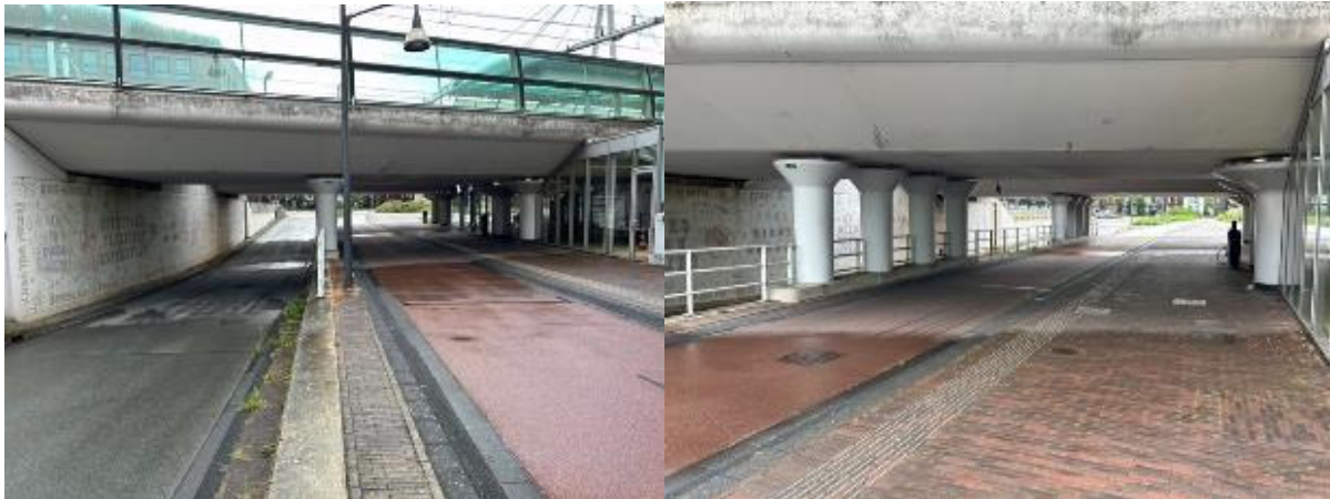
Abbildung 11: Unterführung unter Bahnbauwerk, halber Tunnel für Radfahrende (Quelle: eigene Bilder aus Houten)
