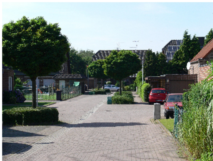
Abbildung 76: Umsetzung mit Mittelrinne und im Mischprinzip, positives Beispiel (Quelle: eigene Fotos)
