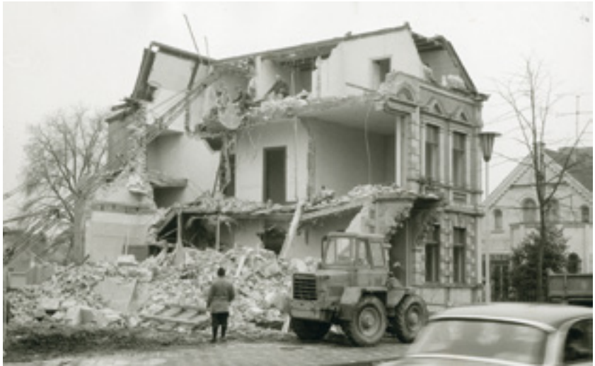
Abbruch des Verwaltungsgebäudes Nassauer Allee 10, 1969 (KA Kle F2, 18)
