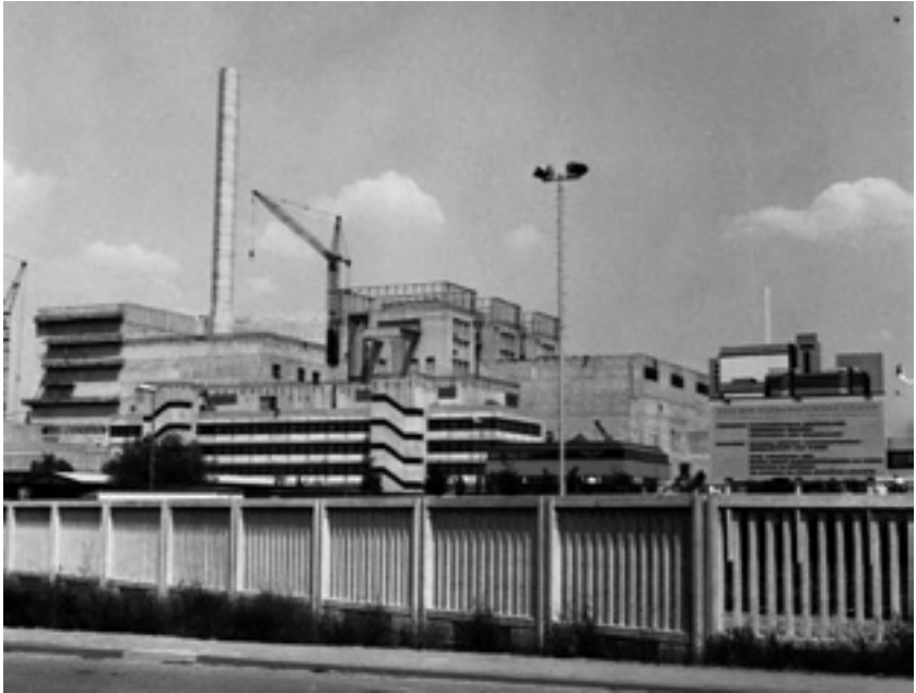
Bau des 1985 fertiggestellten Kernkraftwerkes Kalkar, um 1980, Fotograf: Peter Schiller (KA Kle F3, 10030)
